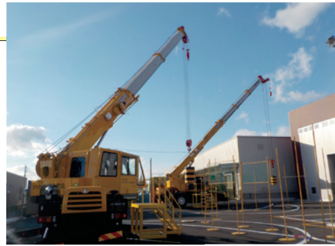
▲移動式クレーン運転実技教習
